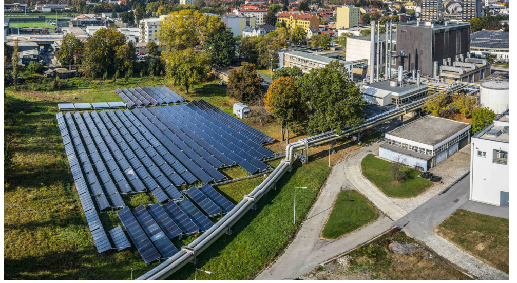
Graz'daki DH tesisinin yanındaki eski çöp sahasında büyük kolektörlerle test alanı
