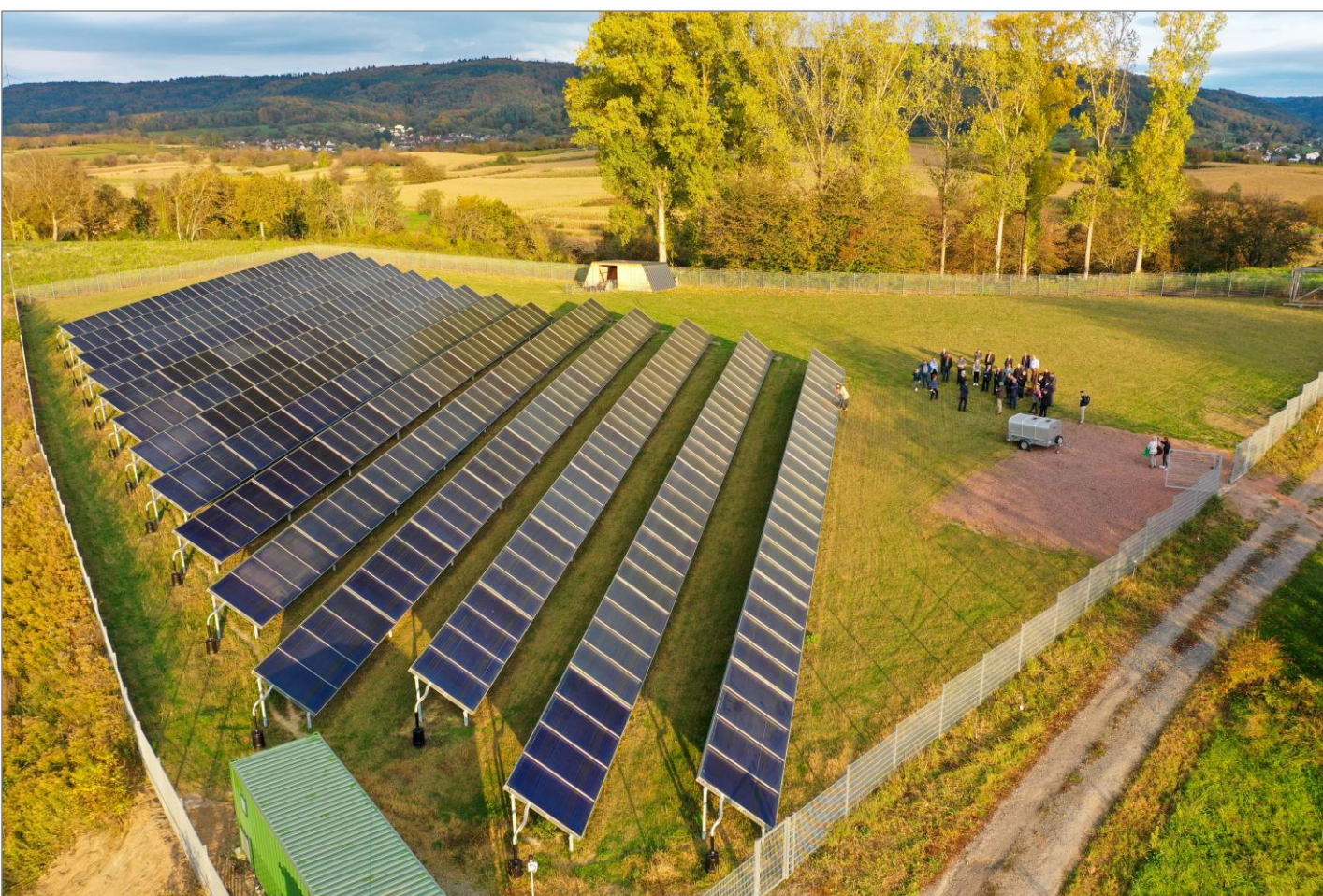
Fernwärme Eettenheim Source: Peter Blaser
