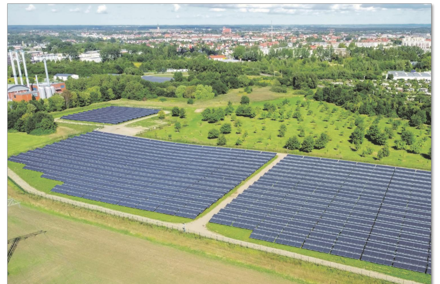
Stadtwerke Greifswald Source: Ritter XL Solar
